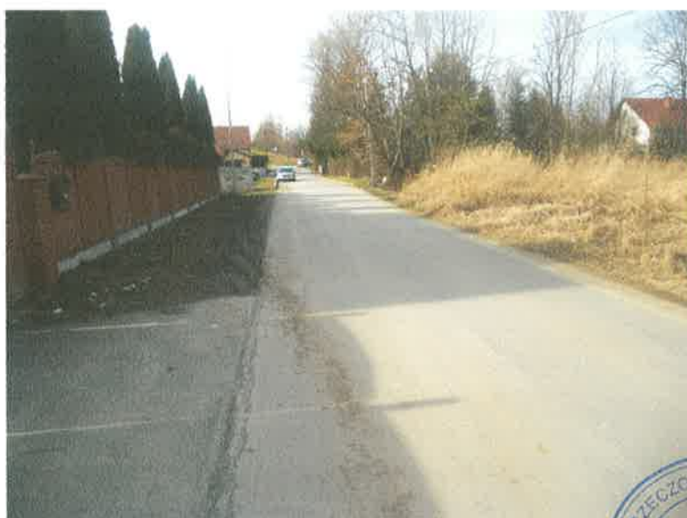
Fragmety drogi dojazdowej
