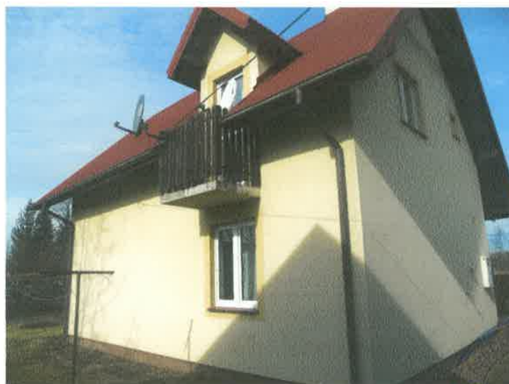
Fragmety budynku mieszkalnego stanowiącego zabudowę działki nr ew. 1832/2 położonej w Dynowie
